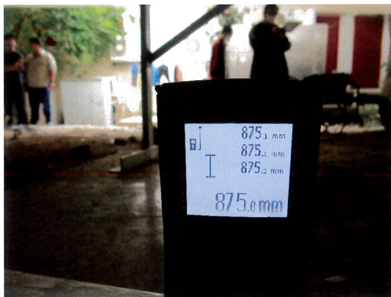
圖 1.12 風管段 6 法蘭接駁位之變形量測試
