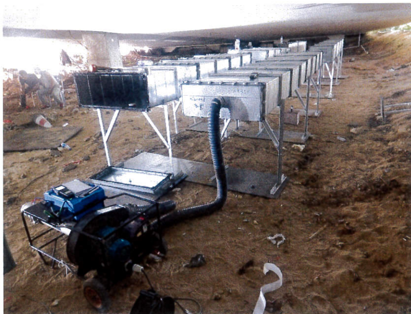
圖 1.3 風管段 2 法蘭接駁位之漏風量測試
