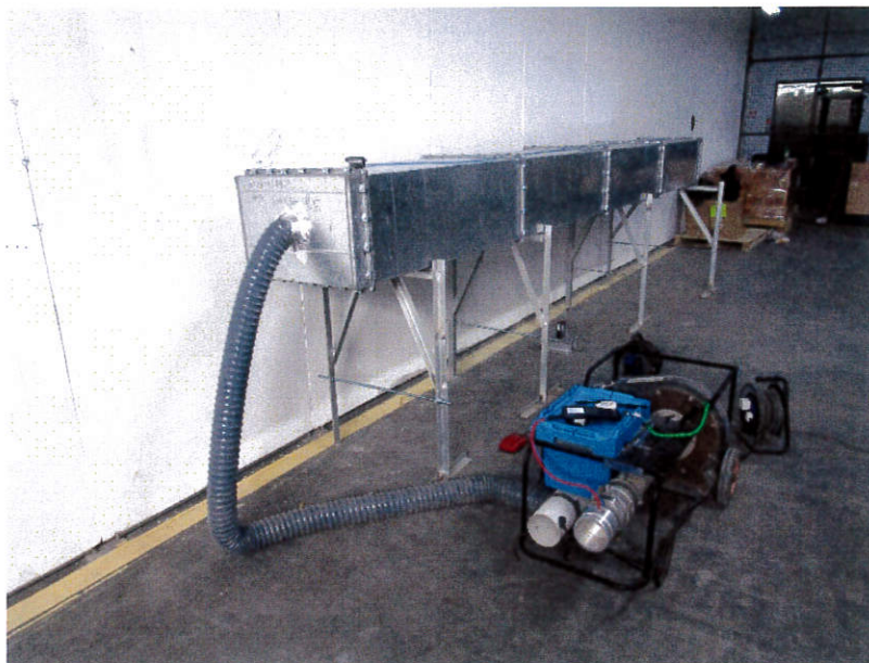
圖 1.1 風管段 1 法蘭接駁位之漏風量測試
