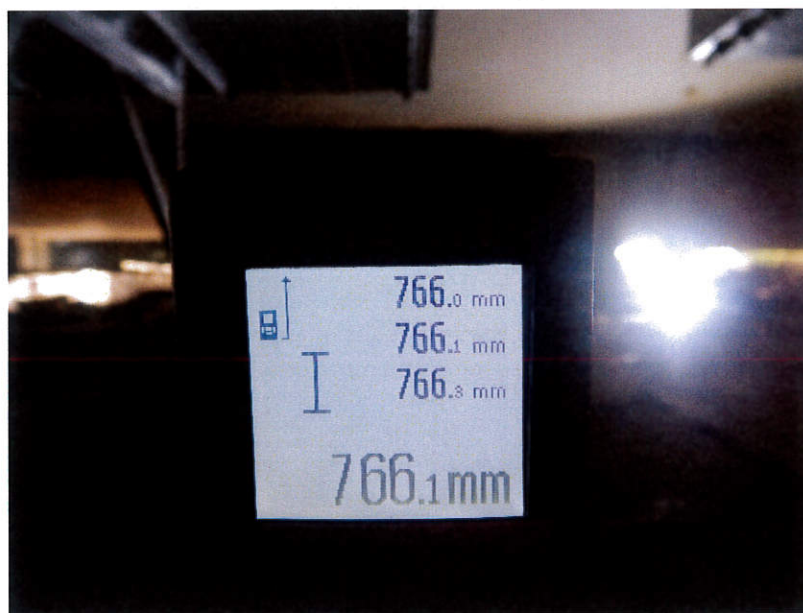
圖 1.4 風管段 2 法蘭接駁位之變形量測試
