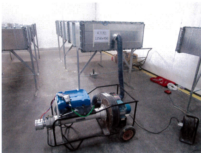
圖 1.7 風管段 4 法蘭接駁位之漏風量測試
