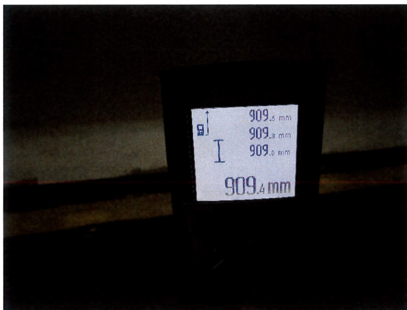
圖 1.2 風管段 1 法蘭接駁位之變形量測試
