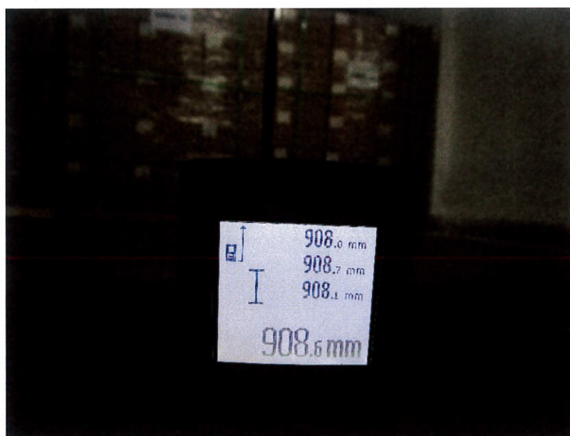
圖 1.6 風管段 3 法蘭接駁位之變形量測試
