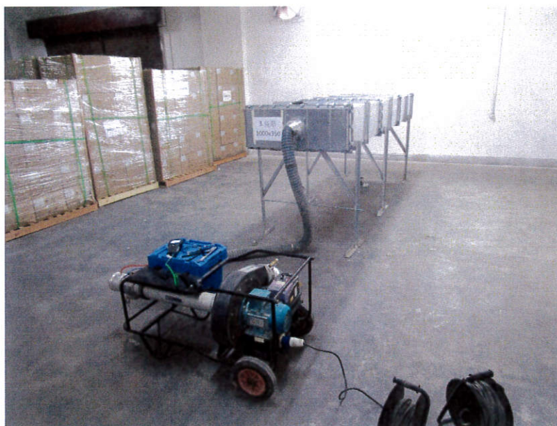
圖 1.5 風管段 3 法蘭接駁位之漏風量測試
