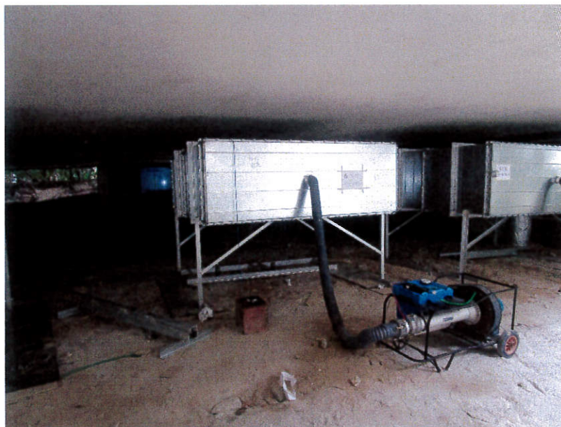
圖 1.11 風管段 6 法蘭接駁位之漏風量測試
