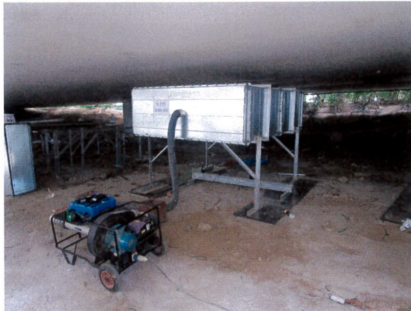
圖 1.9 風管段 5 法蘭接駁位之漏風量測試
