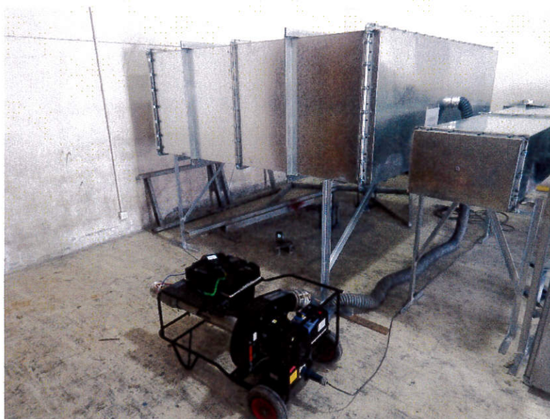
圖 1.13 風管段 7 法蘭接駁位之漏風量測試
