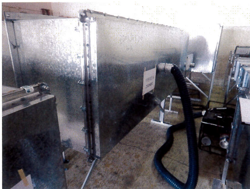
圖 1.11 風管段 6 法蘭接駁位之漏風量測試
