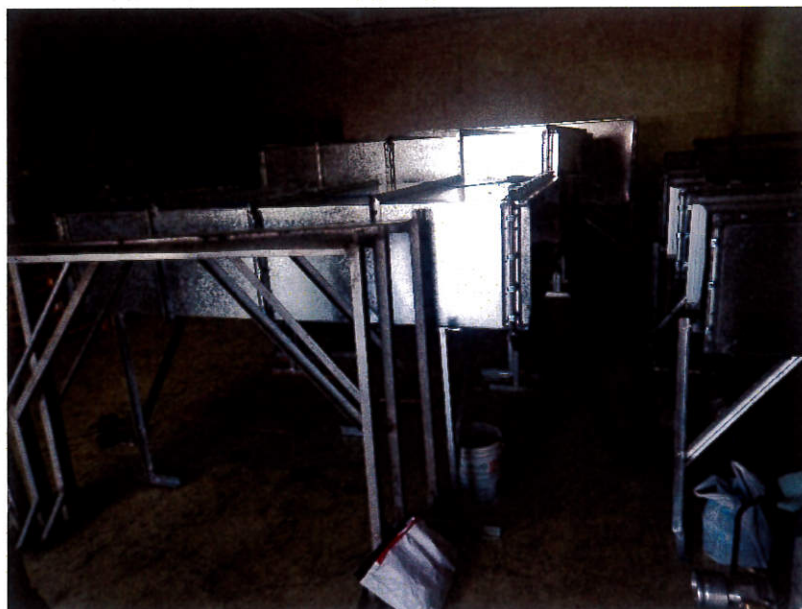
圖 1.9 風管段 5 法蘭接駁位之漏風量測試
