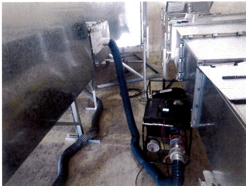
圖 1.1 風管段 1 法蘭接駁位之漏風量測試
