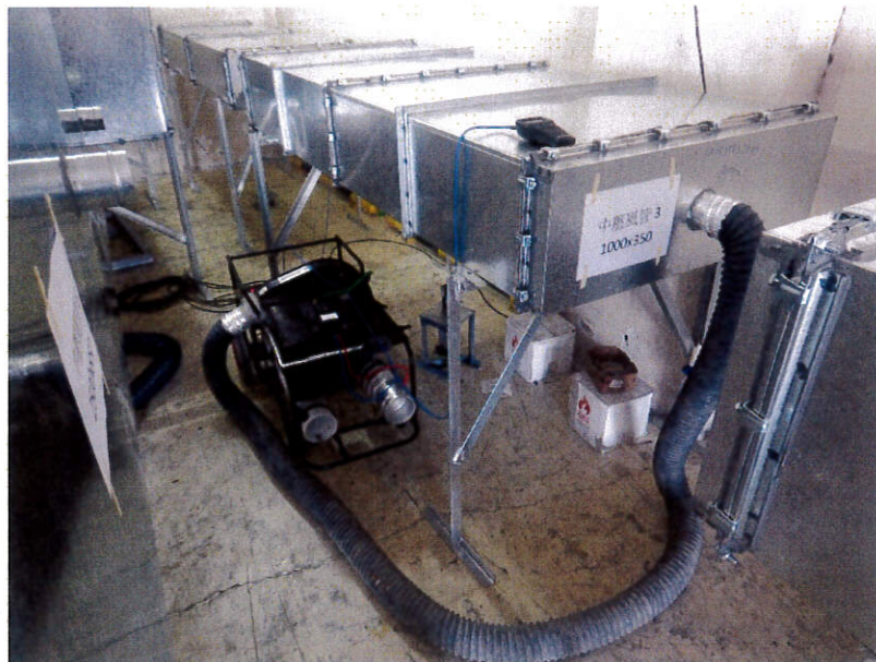
圖 1.5 風管段 3 法蘭接駁位之漏風量測試
