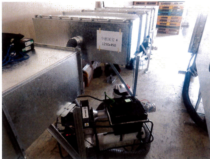
圖 1.7 風管段 4 法蘭接駁位之漏風量測試
