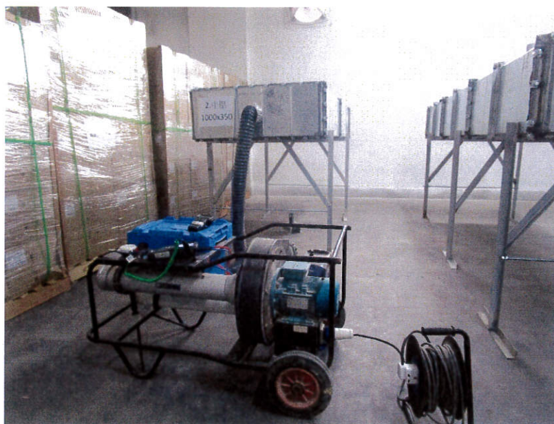
圖 1.3 風管段 2 法蘭接駁位之漏風量測試
