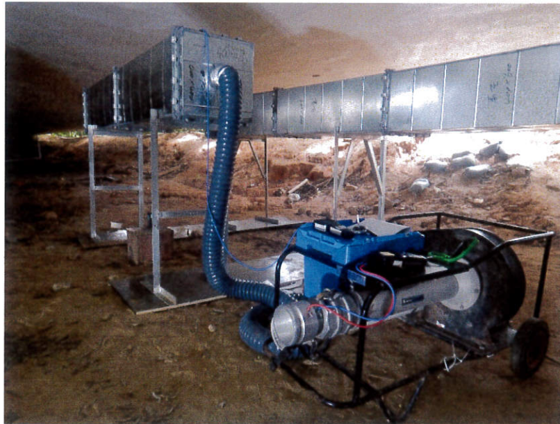
圖 1.1 風管段 1 法蘭接駁位之漏風量測試
