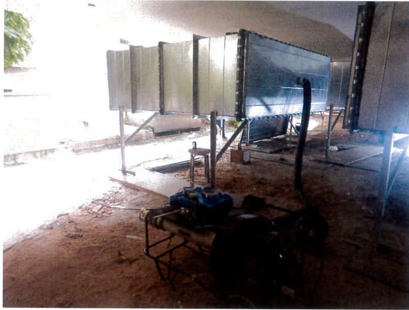
圖 1.9 風管段 5 法蘭接駁位之漏風量測試
