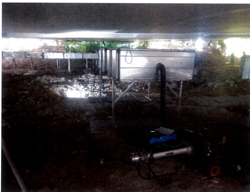
圖 1.7 風管段 4 法蘭接駁位之漏風量測試
