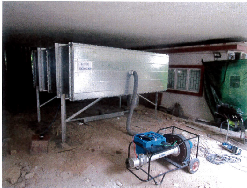
圖 1.11 風管段 6 法蘭接駁位之漏風量測試
