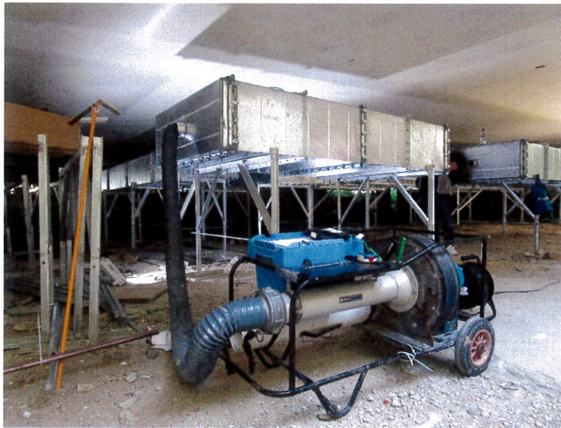
圖 1.5 風管段 3 法蘭接駁位之漏風量測試
